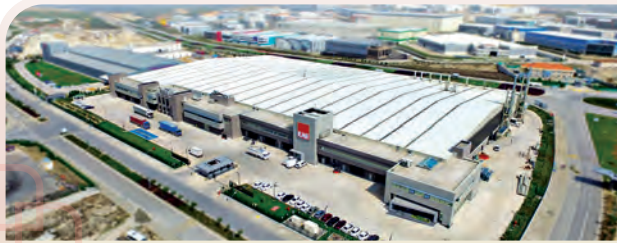
EAE DL 1 Fabrikası Kablo Kanalı
