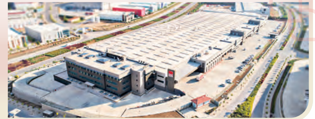
EAE DL 3 Fabrikası Busbar
