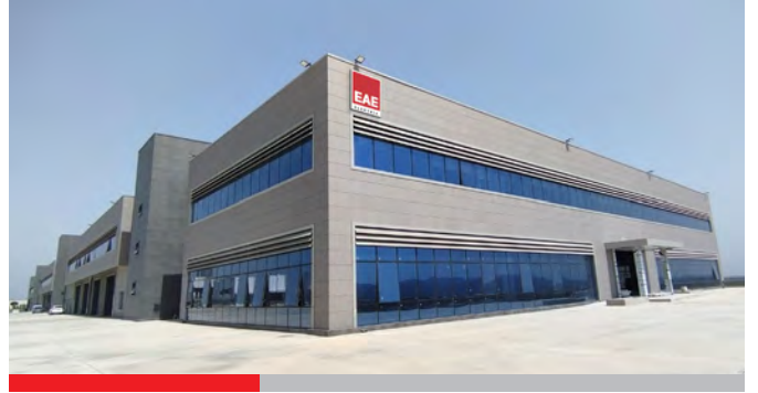
Busbar 2 Fabrikası (DL4) Kocaeli / TÜRKİYE
